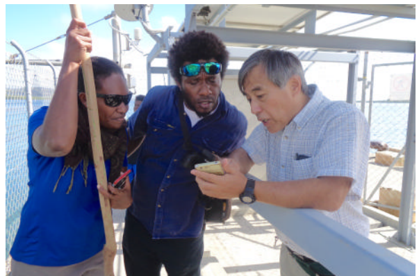
バヌアツで実施中の技術協力「地震・津波・高潮情報の発信能力強化プロジェクト」において、津波用監視カメラを設置して映像を確認している様子 (写真: JICA)
