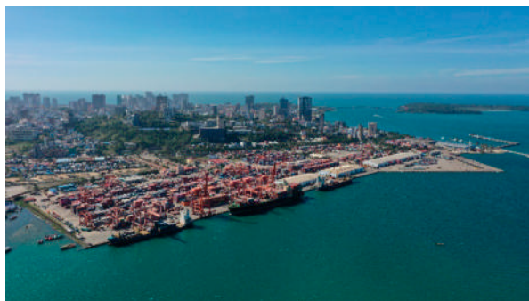
シハヌークビル港の様子。同港はカンボジア唯一の大水深港であり、カンボジアのコンテナ貨物輸出入の約7割を担っている（写真：JICA）。
