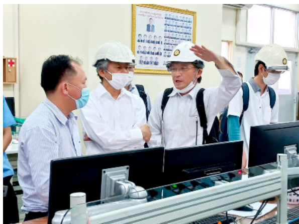
ラオスの電力輸出や安定供給のための系統計画策定や運用を強化するための技術協力での発電所視察の様子（写真：JICA）
