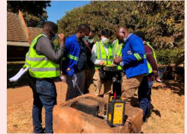
地下漏水探知の技術を指導する関元専門家 (写真：JICA)
