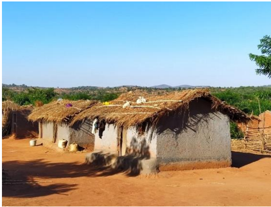
プロジェクト参加前に建設した 対象農家の茅葺屋根の住居
