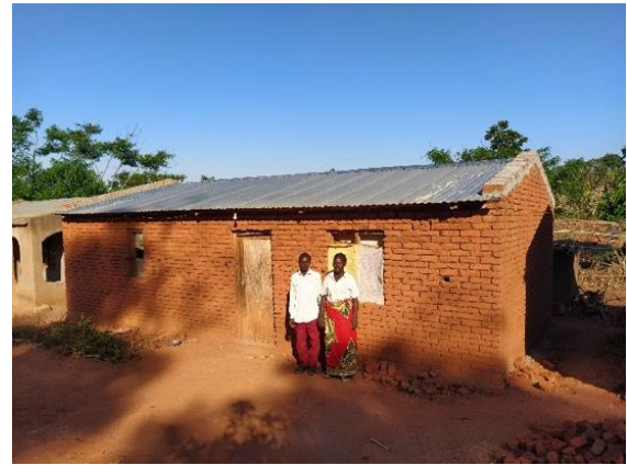
プロジェクト参加後に新築した 同一農家のトタン屋根の住居(建設中)
