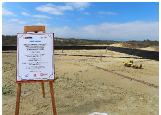
写真: 完工したトゥンベス地区の衛生埋立処分場
