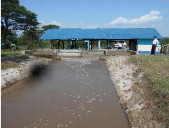
1. 現在の揚水機場
