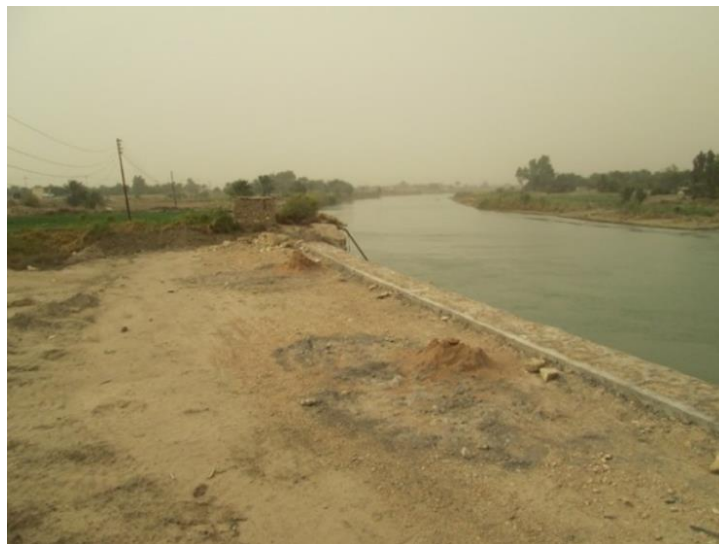
写真 2: 取水施設建設予定地
