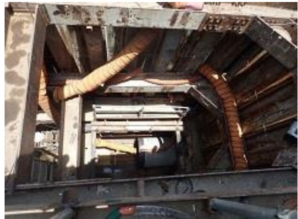
(参考) 第2期ホーチミン市水環境改善 計画 管渠敷設
