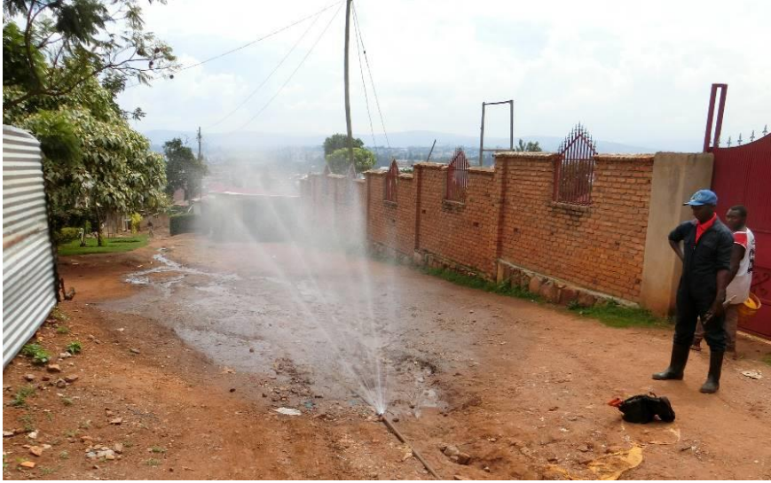
配水管の漏水状況（撮影：事務所担当者）
