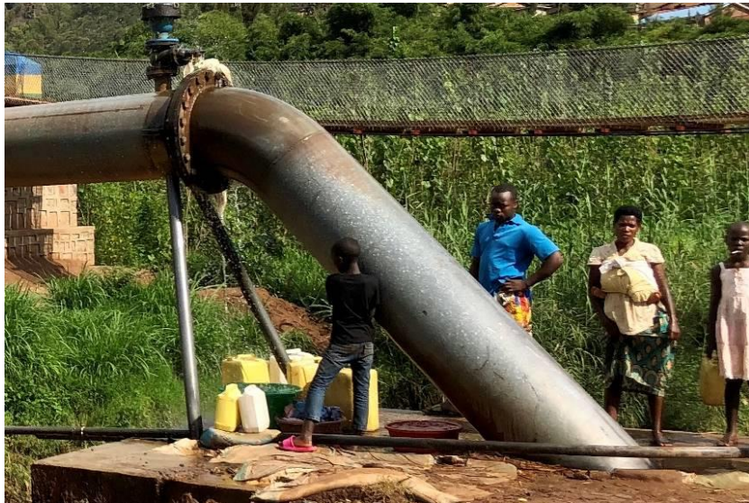
送水管の漏水状況（撮影：技術協力プロジェクトのコンサルタント）
