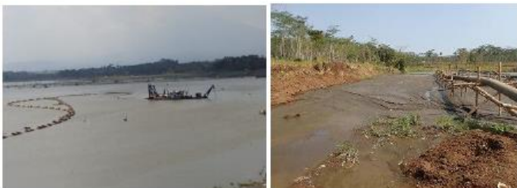
スタミダム浚渫工、土捨場写真
