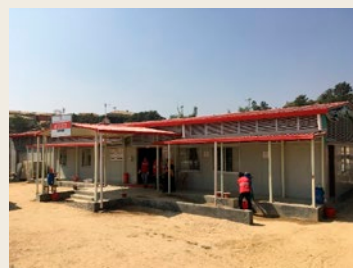
本案件で建設したプライマリヘルスケアクリニック
