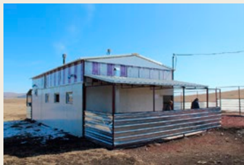
本案件で建設されたバイオブリケット製造施設
