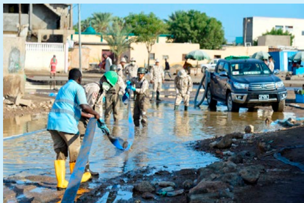
ジブチ当局のスタッフとも協力して中学校での排水作業を行う自衛隊部隊（写真：防衛省）
