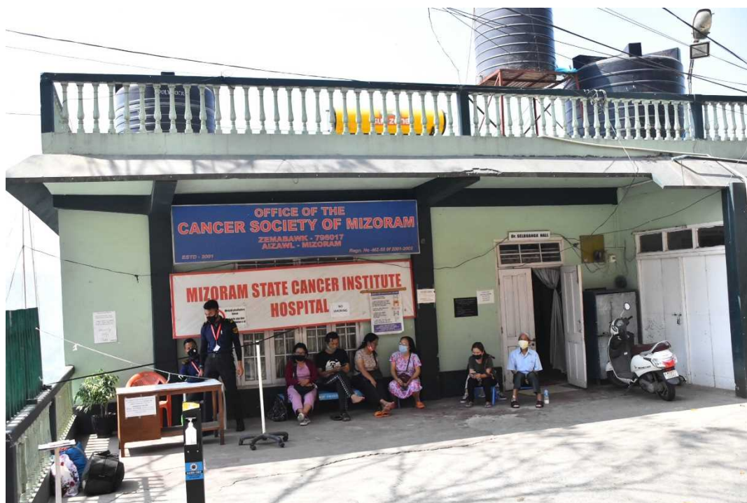
既存の州立がん病院外観
