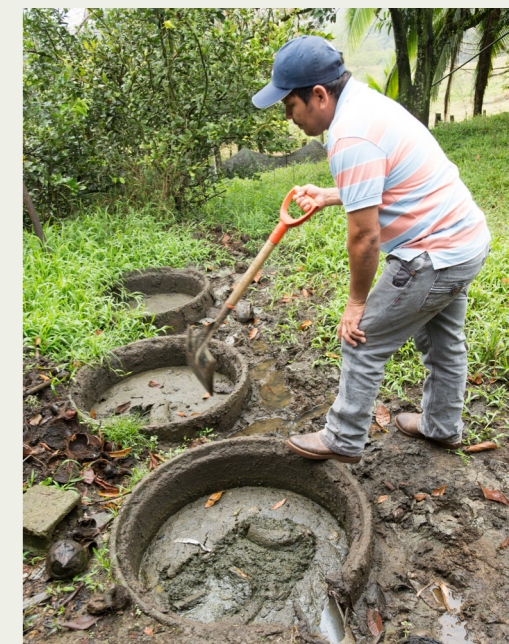
受入槽でバイオガスプラントを作り出す様子(生物多様性保全推進プロジェクト)(コスタリカ) 写真提供: 今村 健志朗 / JICA
