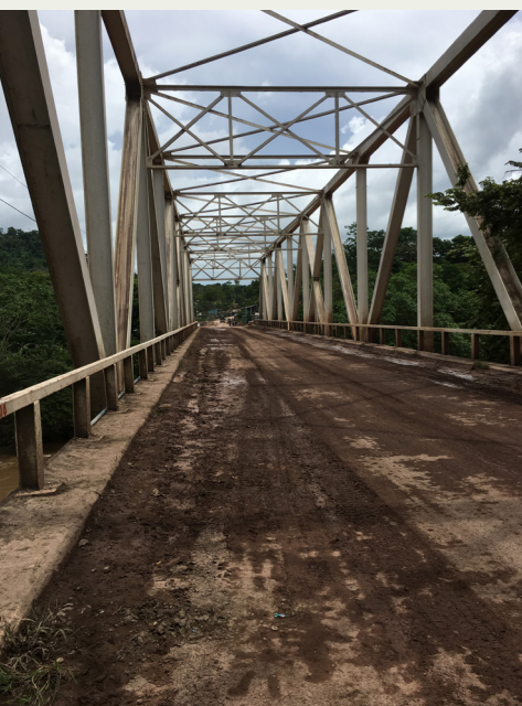
■ ムルクク橋(橋梁・国道整備事業)(ニカラグア) 写真提供: JICA
