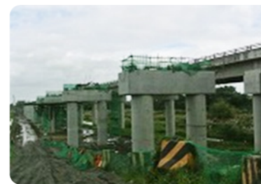
日本企業が円借款で建設中の橋梁
