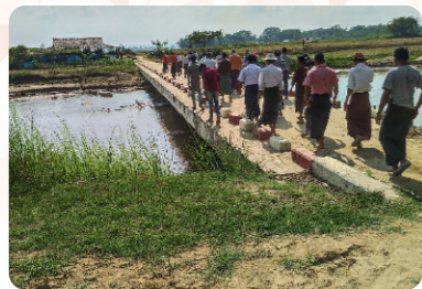
○ N連による沈下橋の建設及び技術移転事業(受益者が橋を利用する様子)
