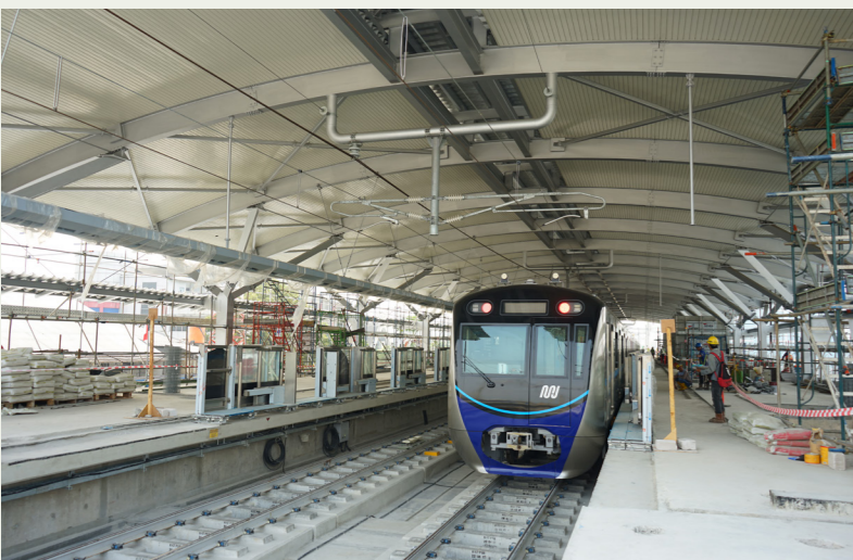
建設中の駅舎と車両(ジャカルタ都市高速鉄道事業) 写真提供: JICA
