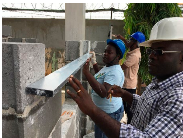
日本が能力強化を支援しているアンゴラの職業訓練センターの建築学科の屋外実習にて、安全第一で作業を行う様子（写真：JICA）
