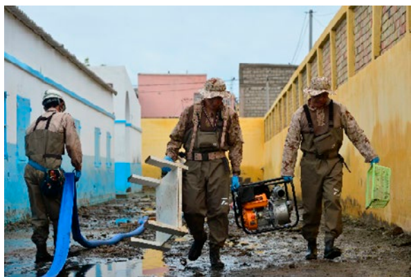
大雨・洪水の被害を受けたジブチ市内の小中学校において、排水および機能復旧作業を行う自衛隊員の様子（写真：防衛省）（53ページの「国際協力の現場から」も参照）
