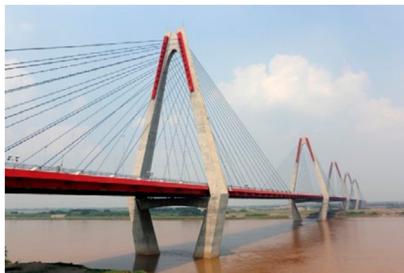
ベトナムにおいて、日本の有償資金協力により建設されたニャットン橋（写真：JICA）
