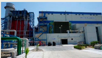
シマル・ガス火力複合発電所2号機の外観 (写真: JICA)
