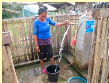
ラオスにおける井戸の建設
