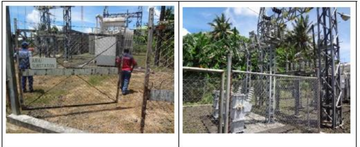
入口と主変圧器
