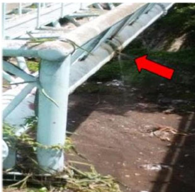
→水管橋 送水管接続部からの漏水
