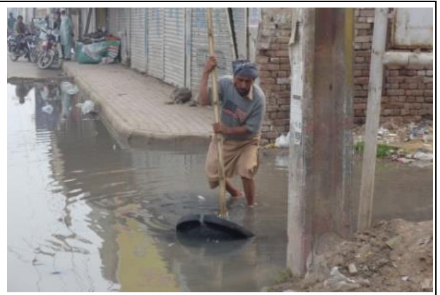
ムルタン：浸水対応をする作業員
