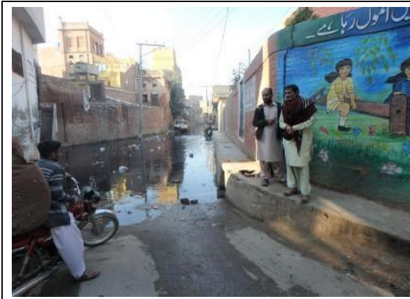
ムルタン：下水管の閉塞による浸水
