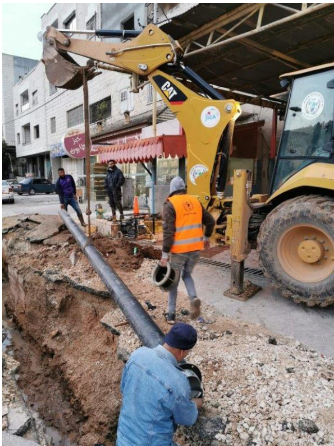
漏水している配水管を交換している様子。漏水が多く発生しており、送配水管全体を整備する必要がある。
