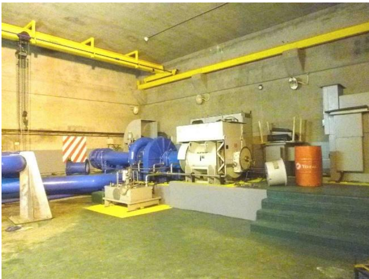
既設小水力発電設備（カツエダム）
