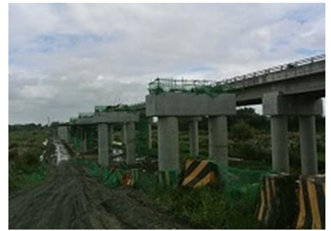
日本企業が円借款で建設中の橋梁
