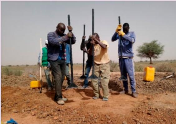
PAPRIZ2の維持管理指導者研修を受講したSAED（セネガル川デルタ・セネガル川ファレム周囲機整備開発公社）普及員の指導の下、2018年1月に行われたポドール県での農民参加型工事による水路締固め作業（写真：JICA）
