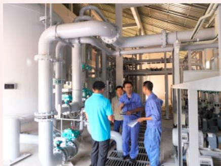
本事業により、ポリカムサイ県パクサン地区に整備された浄水場内部。トーケミの社員が、現地職員に浄水装置の運転指導を行っている。（写真：トーケミ）
