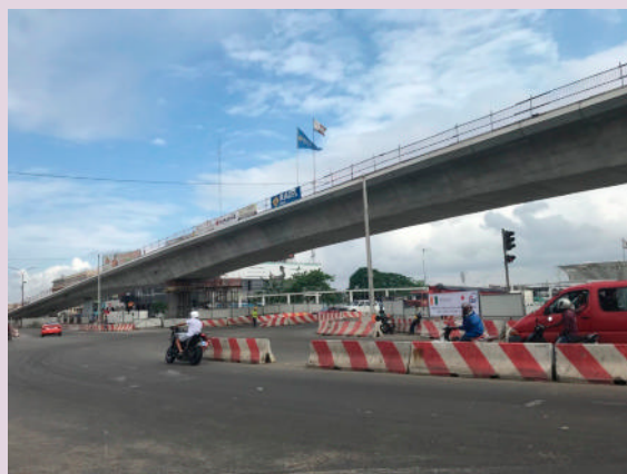
工事中の日本・コートジボワール友好交差点（写真：JICA）
