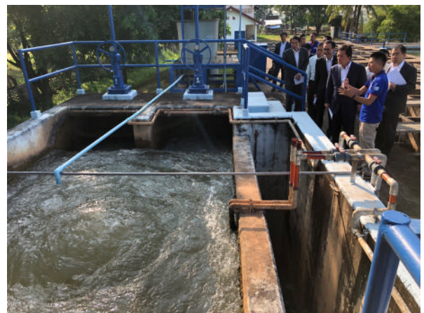
若宮健嗣外務副大臣（右から3番目）が、日本のODAにより改修されたラオスの首都ビエンチャン南部のチナイモ浄水場を視察した時の様子（2019年10月）
