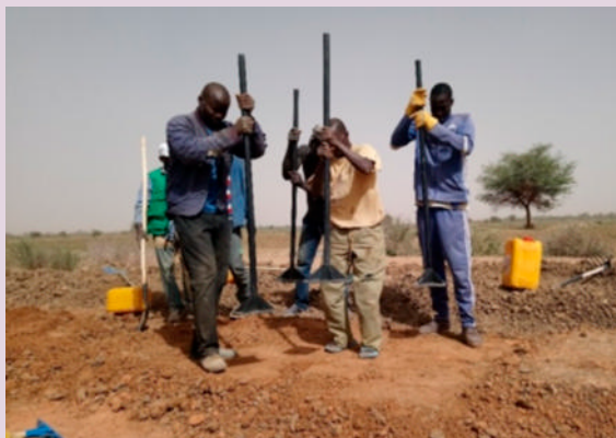
PAPRIZ2の維持管理指導者研修を受講したSAED（セネガル川デルタ・セネガル川ファレメ周田機整備開発公社）普及員の指導の下、2018年1月に行われたポドル県での農民参加型工事による水路締固め作業（写真：JICA）
