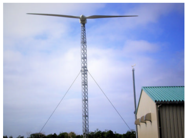
風力発電システム整備計画によりトンガに設置された可倒式風車 (写真：JICA)
