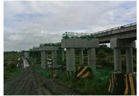
日本企業が円借款で建設中の橋梁
