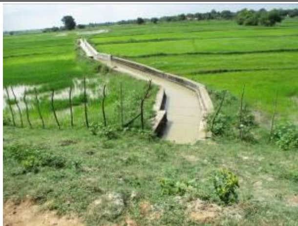
キランダ貯水池の用水路 修理も完了し、より多くの田畑に水が供給できるようになった。
