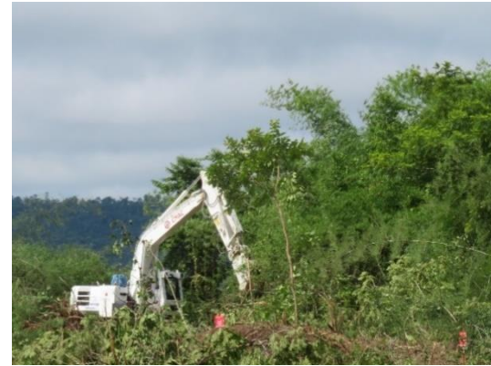
灌木除去機による竹藪の処理
