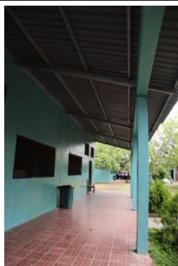
改修された通路床
