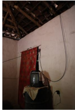
住民宅内の電気のスイッチ
