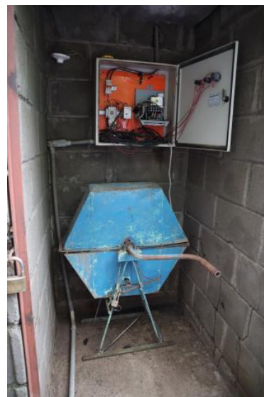
電動水中ポンプ稼動用の 電源盤ボックス
