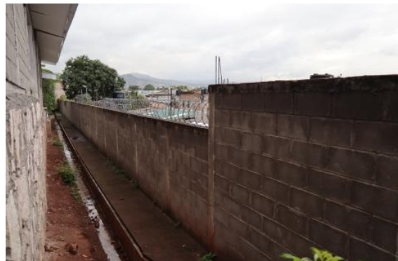
草の根無償により修復された周囲壁
