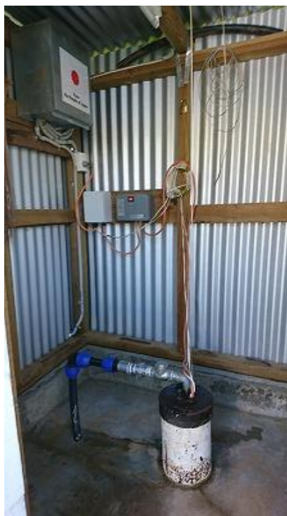
今回の支援で設置した給水ポンプとタンク
