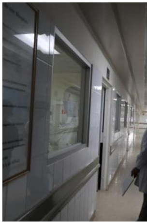
患者が廊下から観察しやすくなった窓(左)と抗菌材を使用した床(右)。天井部も修復された
