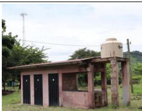
建設したトイレ外観とトイレ内部
