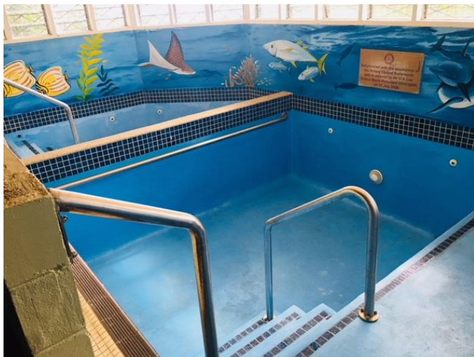
太陽光熱給湯器を使った温水プール
