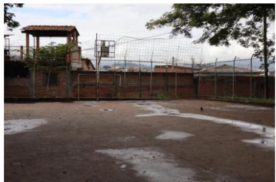
草の根無償によりコンクリート製になった運動場の床
