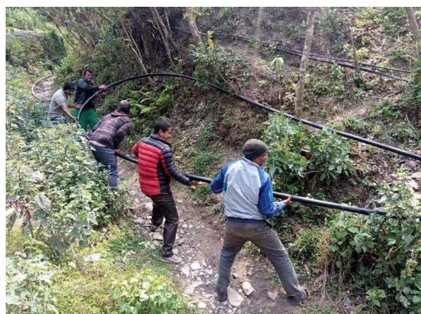
灌漑設備建設（パイプの設置作業を行う地元住民）
