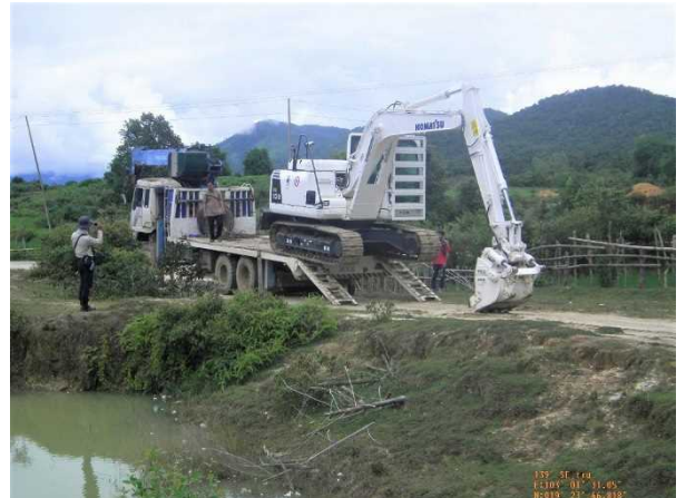
新しい処理地に移動するため、処理機をトレーラーに積載する現場
