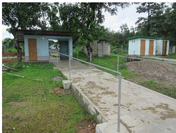
新設したバリアフリースイレと通路
