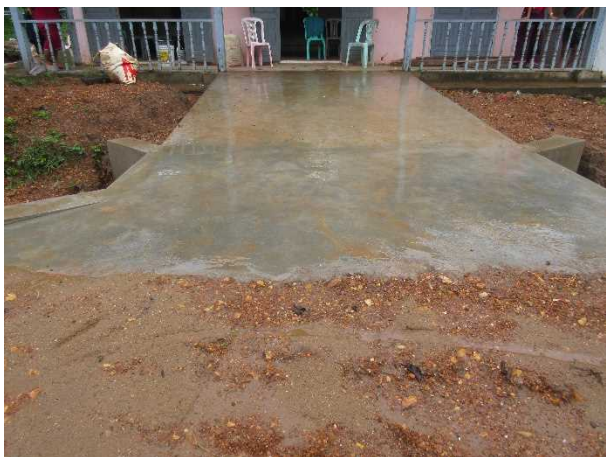
入口をバリアフリー化した区の事務所
