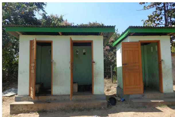
バリアフリー化工事前の小学校のトイレ
