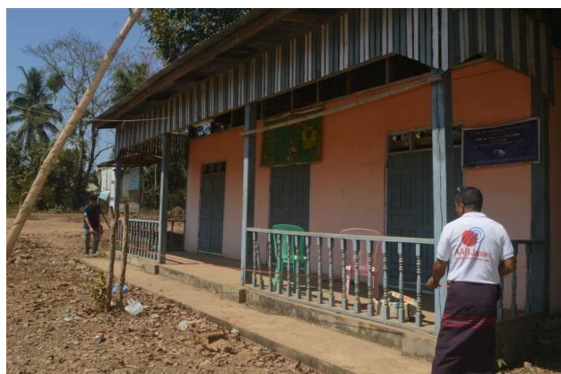
バリアフリー化工事前の区事務所
