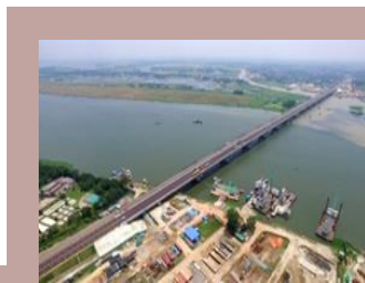
有償資金協力により、2019年5月に開通したバングラデシュのグムティ第2橋
