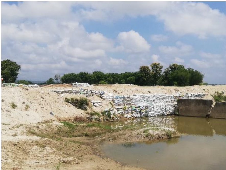
崩壊した排水用サイホン流出部の応急対策状況
