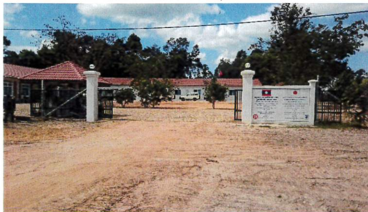
完成した訓練センター
