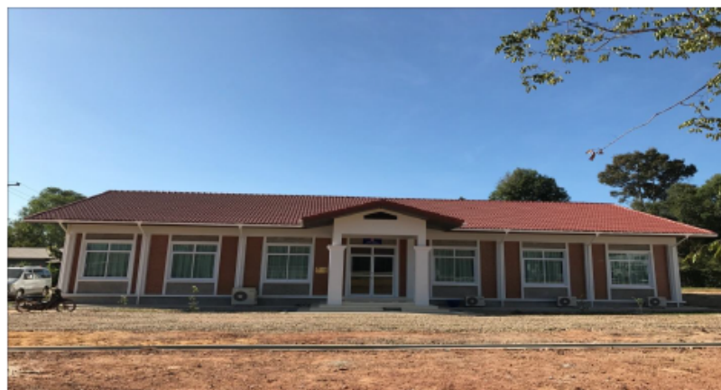
完成した本部建屋全景
