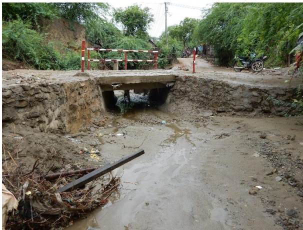
施工後の様子（マグウェ地域チャウ地区）
