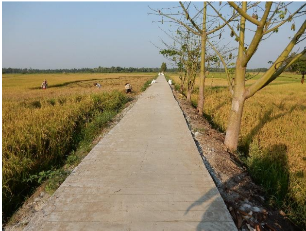
施工後の様子（エーヤワディ地域）
