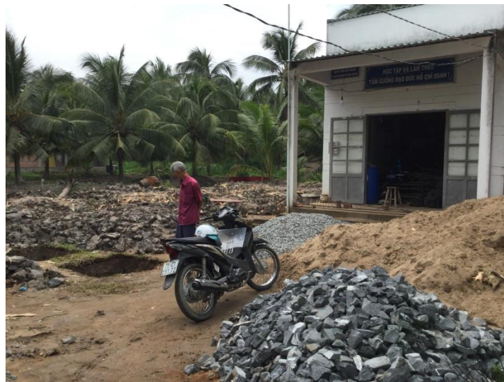
加工所を建設するための準備（ビンダイ郡）。
