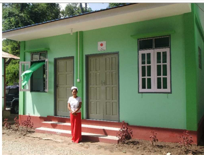
インパコンサブセンター分娩室の建築
