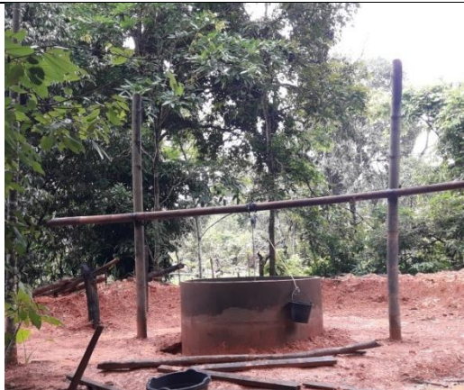
コンクリートリングの設置
