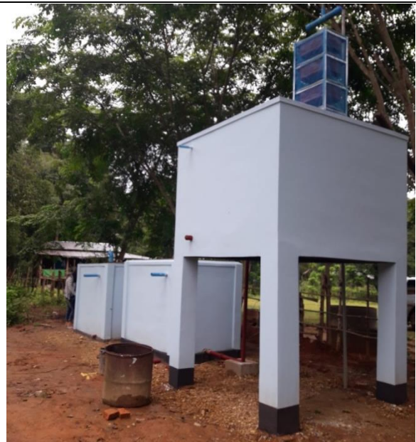
緩速ろ過システム(パヤゴト村) (川の水を炭・砂利・砂の層を通し浄水する)
