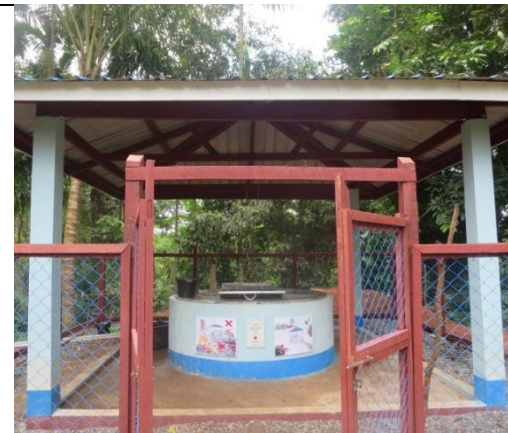
新規開放井戸工事完了
