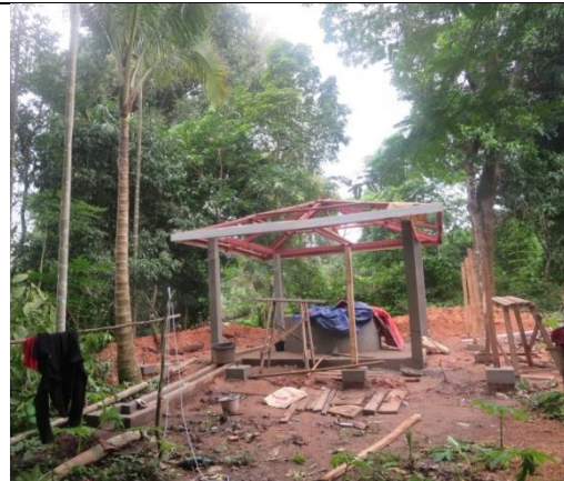
オーバーヘッド施設建設
