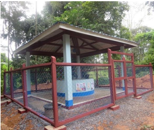
新規開放井戸工事完了
