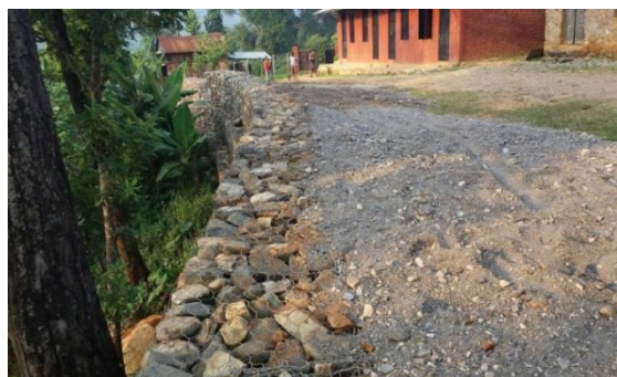
ロタール・学校裏の崖に設置した土砂崩れ防 止壁
