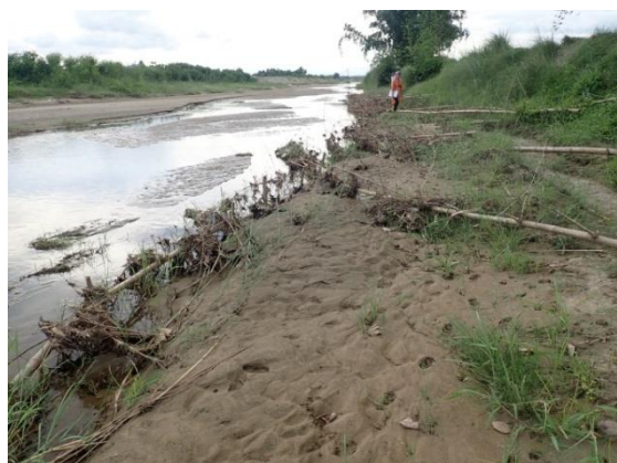
マディ・雨期に破損したインフラを住民が修 繕した箇所
