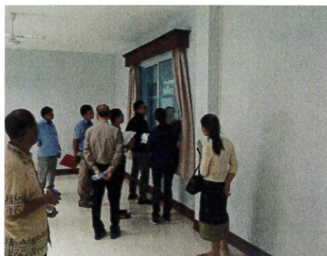
完成した設備の点検を行う JMAS 専門家
