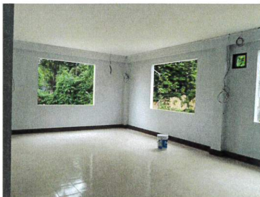
床張りが完了した隊員用居室内
