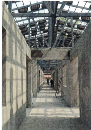
瓦屋根設置前の廊下
