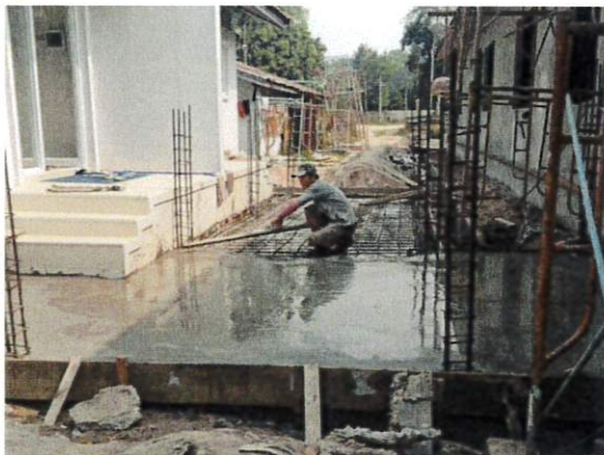
渡り廊下コンクリート打設
