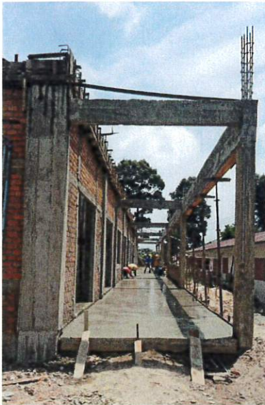
建設中の教場
