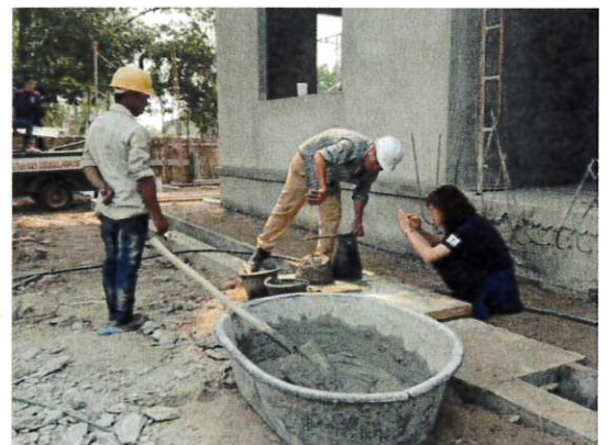
コンクリートテストを確認する建築専門家技術補佐
