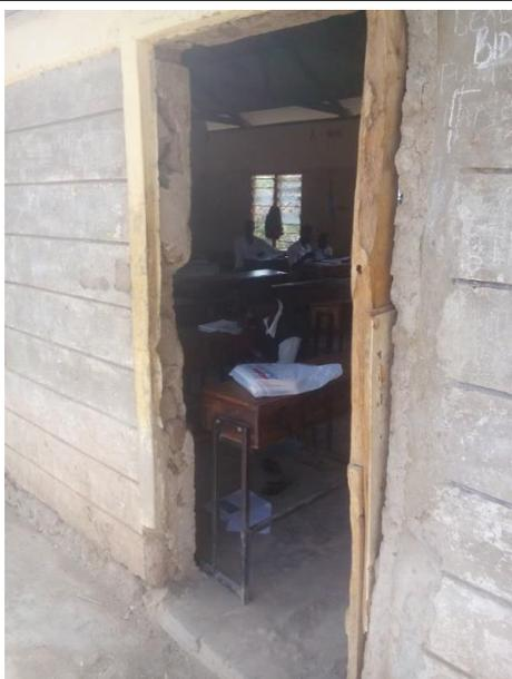
補修前の中等校の教室の扉。木枠が脆くなり変形していた（2017年8月3日）
