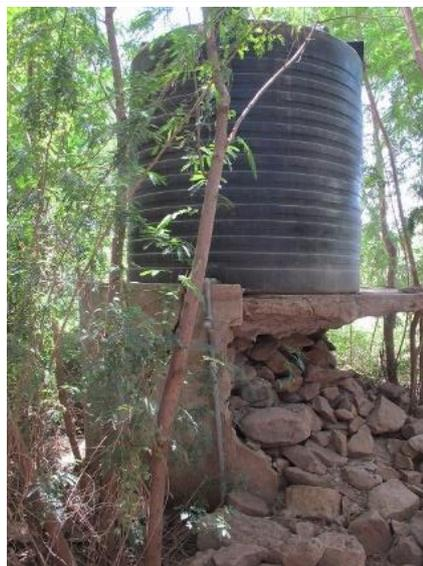
学校に設置されている給水タンクは土台が崩れ、倒壊の危険があった（2017年8月3日）
