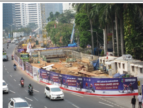
建設中の MRT（ジャカルタ）
