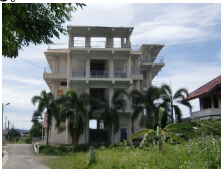
日本の支援により建設された避難タワー（バンダアチェ市ムラクサ郡アル・デア・テウンゴ村）
