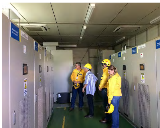
同発電所内の視察
