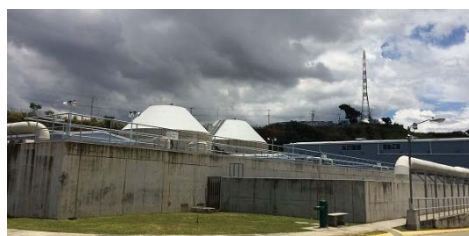
日本の協力により整備されたサンホセ下水処理施設
