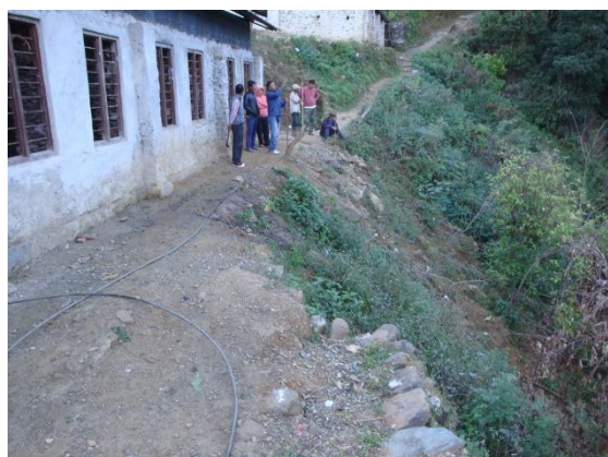
旧ロタール VDC 地区（カンダ）・インフラ 設置前の様子
