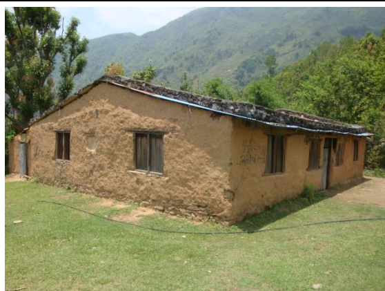
旧ロタール VDC 地区・ 土砂崩れ防止壁設置予定地にある学校
