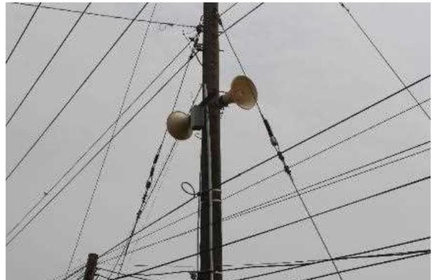
本事業により設置した緊急時警報システムの拡声器
